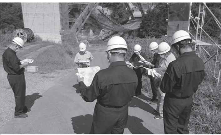
◀(仮称)笠倉壁田橋の工事現場
