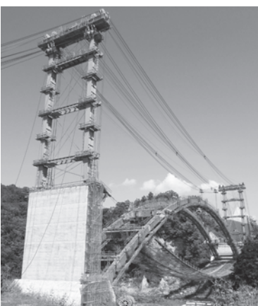
◀建設中の(仮称)笠倉壁田橋
