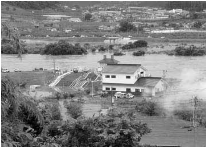
本沢川樋門付近 増水時
