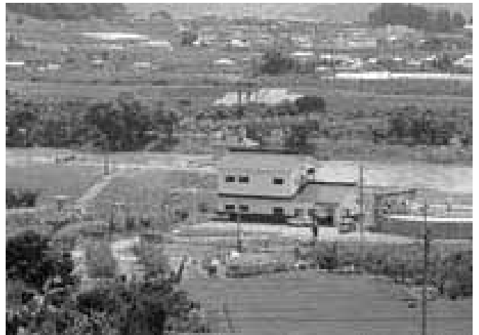
本沢川樋門付近 通常時
