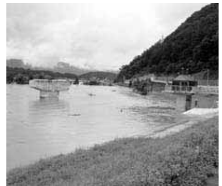
岩井 新幹線橋脚 増水時
