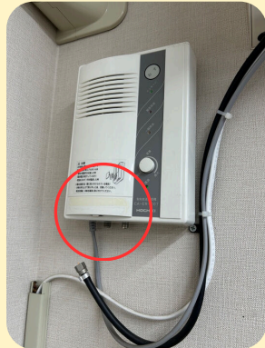
② 端末機から同軸ケーブルを抜きます。
