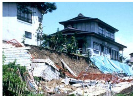
擁壁の倒壊による宅地被害の事例
