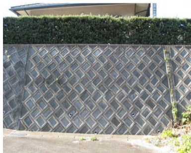
間知ブロック積み擁壁
