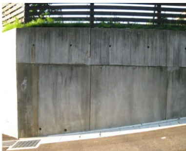
鉄筋コンクリート擁壁
