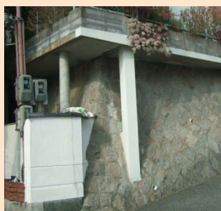
張出し床版付擁壁
