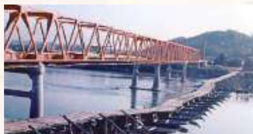
▲建設中の腰巻(古牧)橋 手前が蓮、奥が壁田。左側が下流(飯山方面)。腰巻舟橋の約10m下流に腰巻(古牧)橋が建設された。(出典:守谷商会五十年史)
