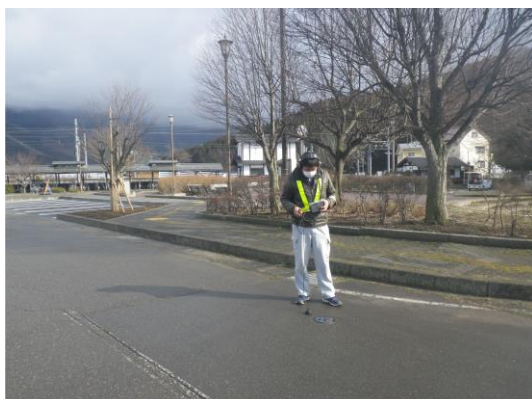
【電子式漏水発見器による調査】
