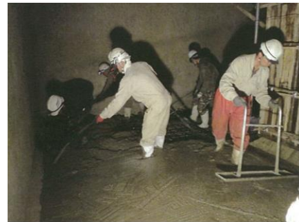
【配水池内部底盤の補強】
