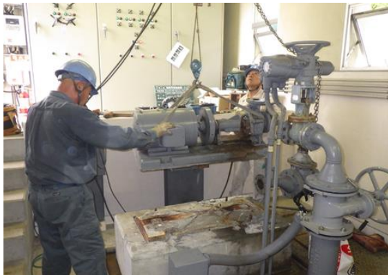
【老朽化したポンプの撤去】
