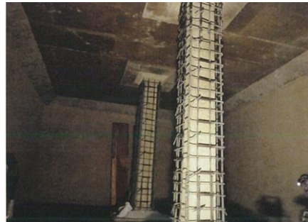
【配水池内部底盤の補強】
