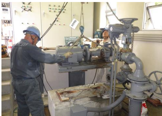
【老朽化したポンプの撤去】
