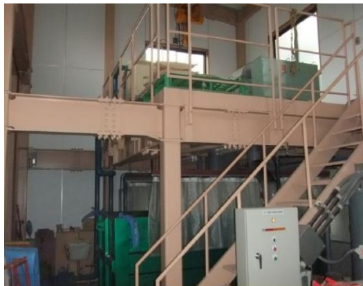
【汚泥脱水機装置】
