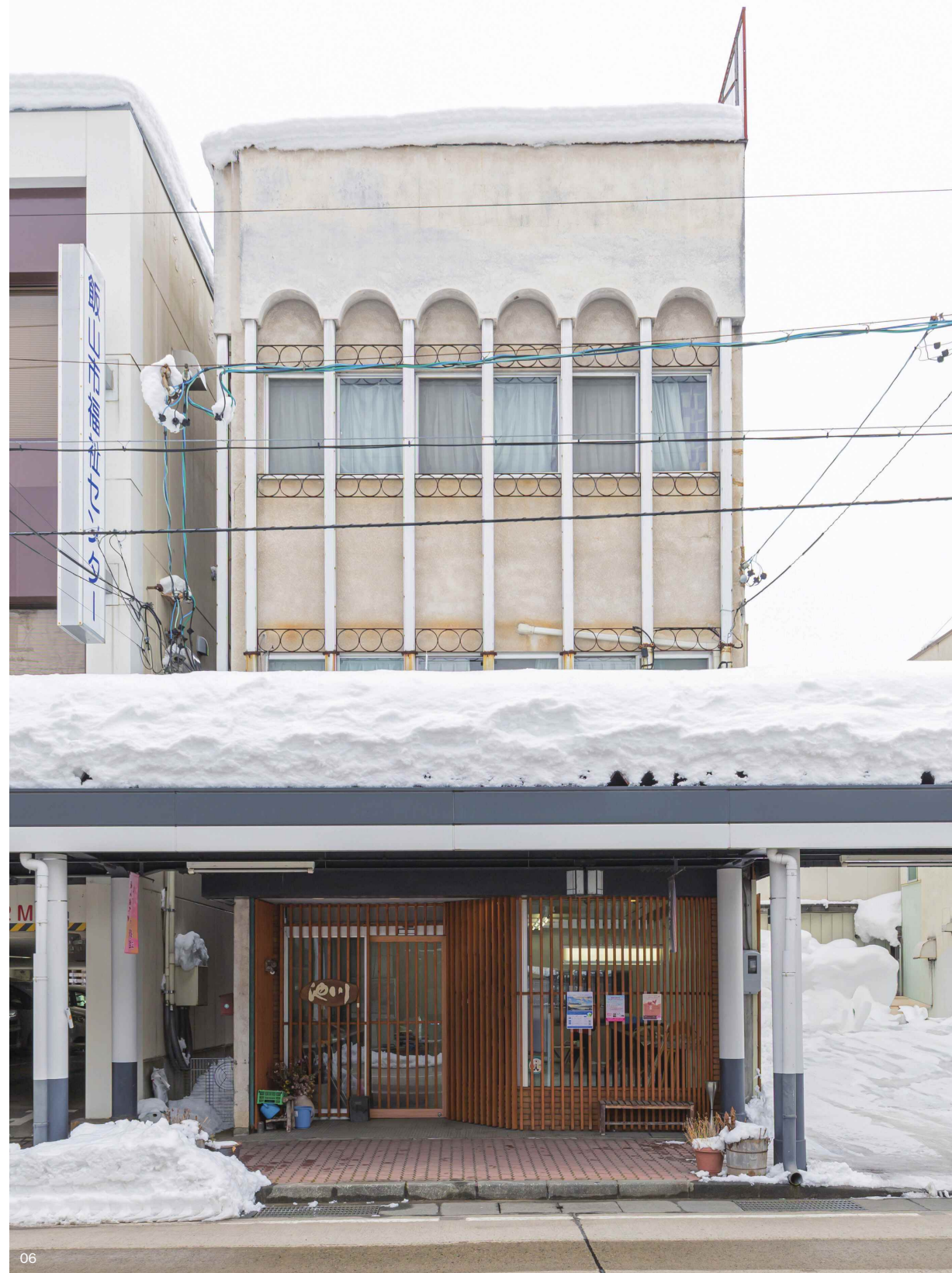
06：築50年程になるレトロビル。ファサードのアーチとアイアンモチーフがかわいい。左隣は社会福祉協議会、駐車場を挟んで右隣は「空楽」。アーケードに積もった雪が豪雪地であることを物語る
