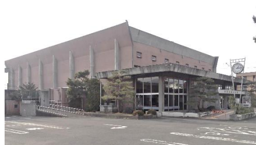
▲市民会館ホール棟
