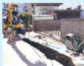
▲市道西町15号線の水道管路布設替え工事。
