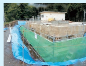
▲赤坂配水池の耐震補強工事。
