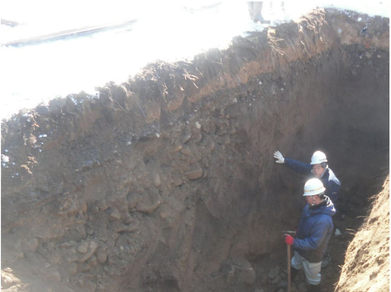
壁面精査状況
