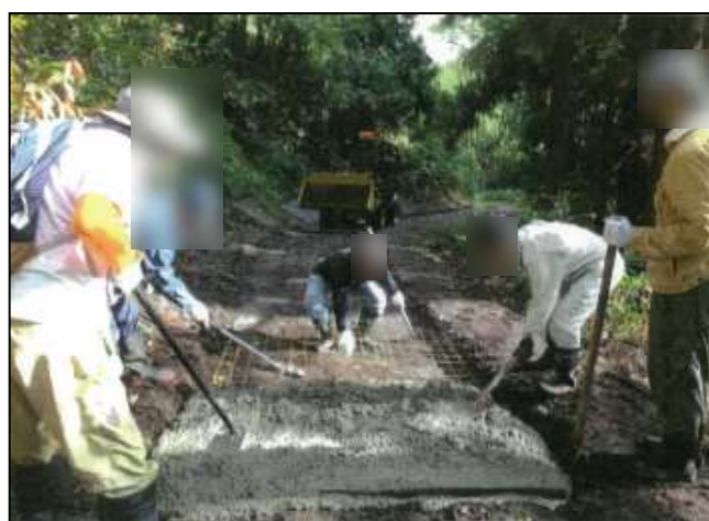
協働作業状況
