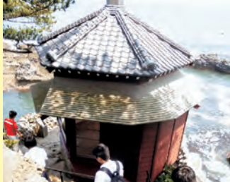
▲再建された六角堂
