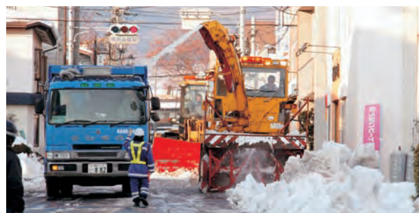
▲市街地における除排雪作業の様子
