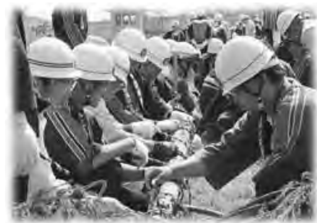
水の流れを緩やかにするための「木流し工法」を実施中
