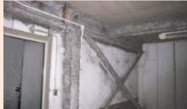
（壁・柱・天井等に吹付けられたアスベストの例）
