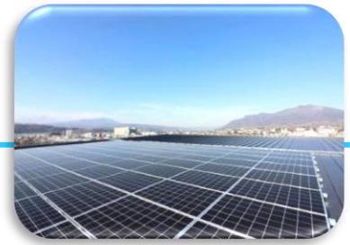
市役所本庁舎の太陽光発電設備
