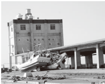
北茨城市(大津漁港)被害状況 (H23.3.14)
