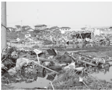
仙台市被害状況 (H23.3.19)
