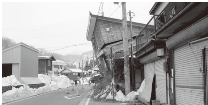
栄村の被害状況 (H23. 3.15)
