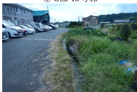
②旧八十二銀行中野西支店裏の水路
