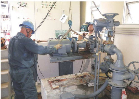
【老朽化したポンプの撤去】
