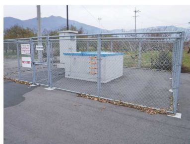
田麦第3水源（深層地下水取水）
