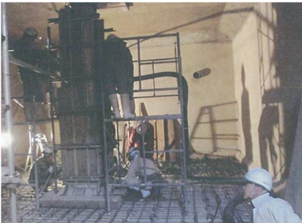
【配水池内部の柱補強】
