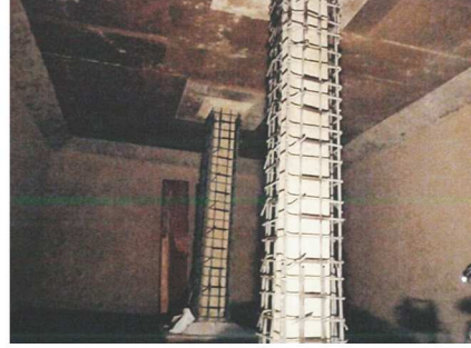
【配水池内部底盤の補強】
