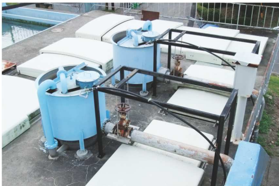
【高速凝集沈澱池の状況】
