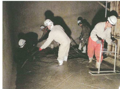
【配水池内部底盤の補強】
