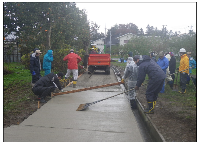
協働作業状況
