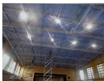
体育館照明改修（LED化） （南宮中学校）
