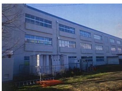
校舎外壁改修 （中野小学校）
