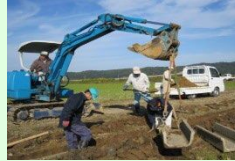
コンクリート水路の更新
