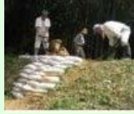
漏水箇所の補修
