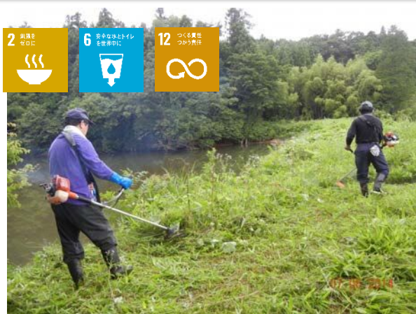
ため池堤体の草刈り
