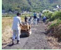
未舗装農道の舗装
